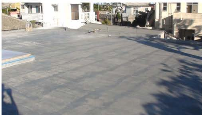
上：外壁塗装中の様子 下：下地処理後、塗装前の屋根部分
